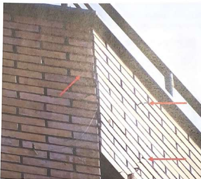
Фото 20. Ось Е1 758 Диагональные трещины наружной версты. Вертикальная трещина парапетной зоны.
