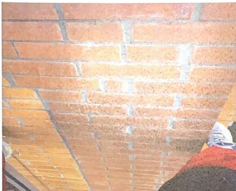
Фото 91. Секция 11. Фасад 2. Участок восстановления кирпичной кладки фасада- значительных дефектов не выявлено.
