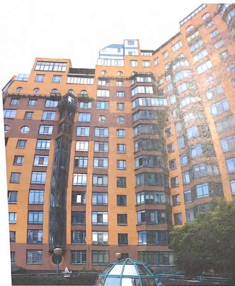
Фото 17. Секции 7-8. Дворовой фасад. По исполнительной схеме Фасад 3.
