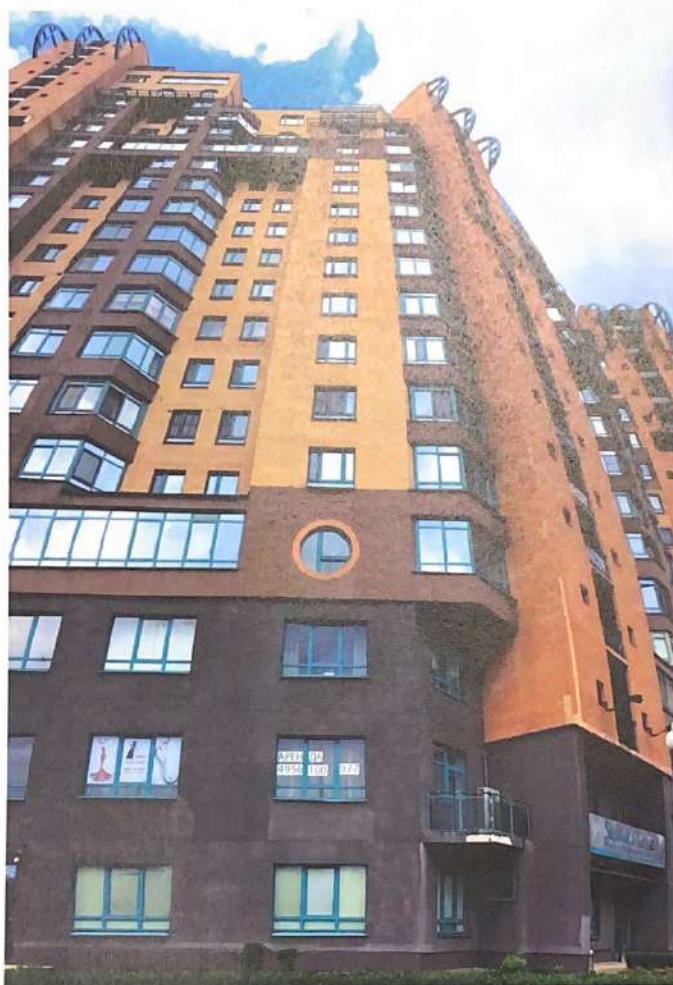
Фото 3. Секция 8. По исполнительной схеме Фасад 1.
