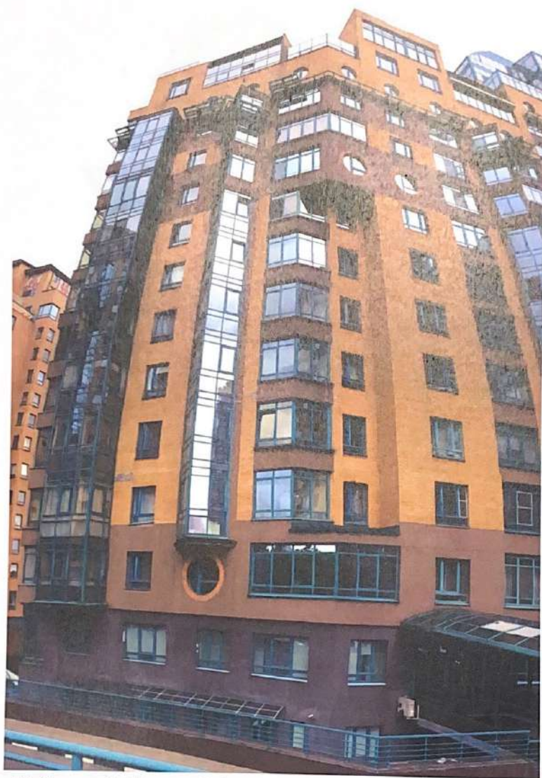
Фото 18. Секция 7. Дворовой фасад. По исполнительной схеме Фасад 3.
