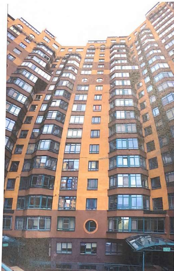
Фото 16. Секция 9. Дворовой фасад. По исполнительной схеме Фасад 3.
