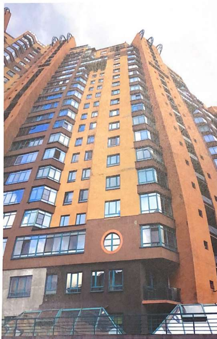
Фото 6. Секция 10. По исполнительной схеме Фасад 1
