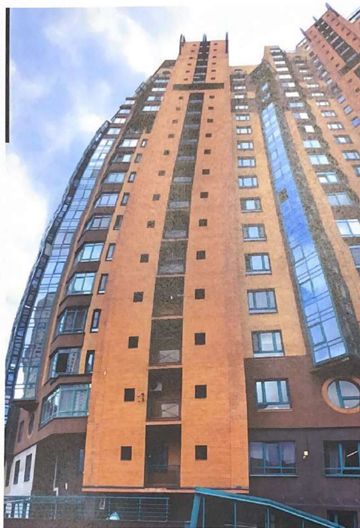
Фото 9. Секция 12. По исполнительной схеме Фасад 2.
