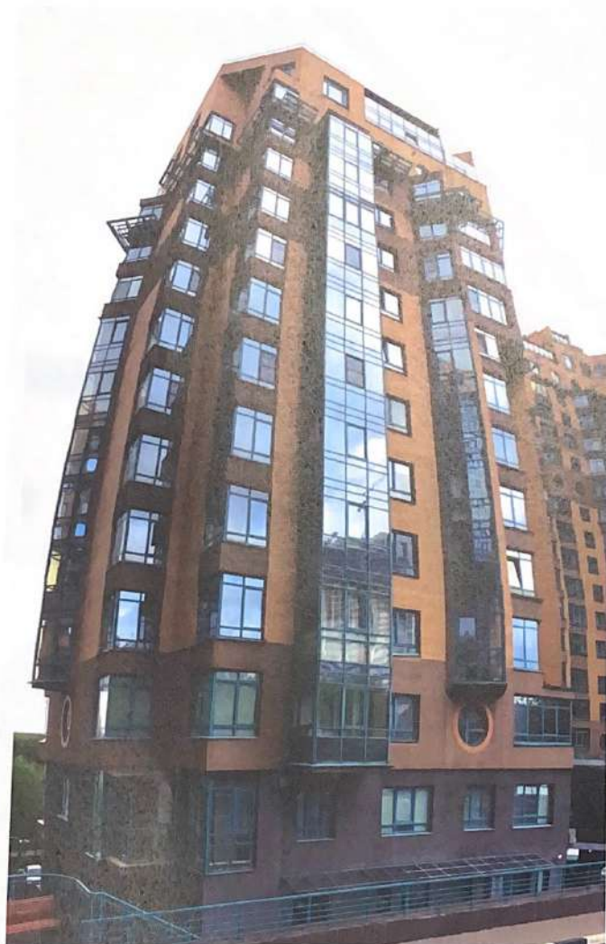
Фото 19. Секция 7. По исполнительной схеме Фасад 3.
