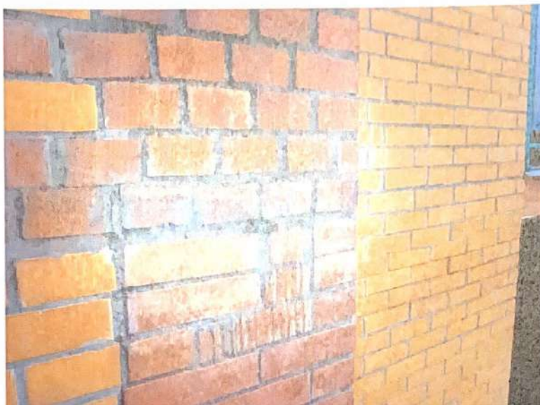
Фото 93. Секция 11. Фасад 2. Участок восстановления кирпичной кладки фасада- значительных повреждений не выявлено
