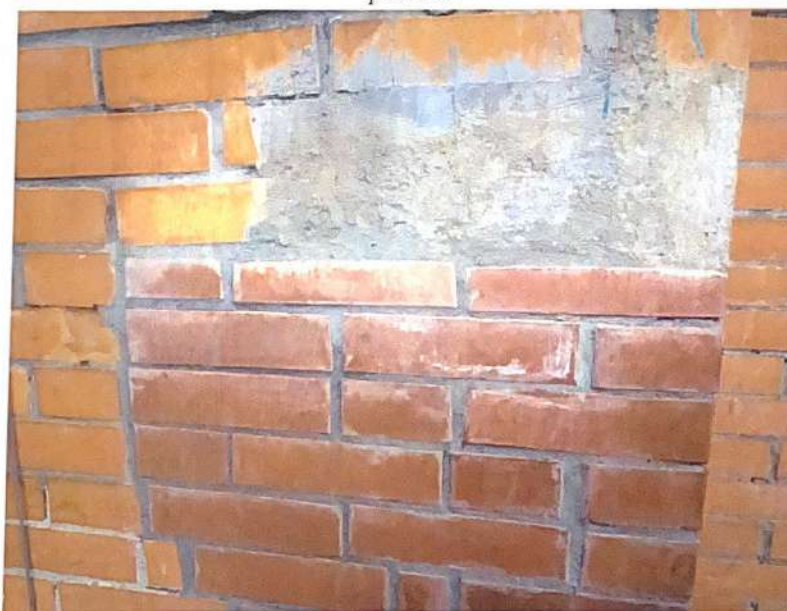
Фото 90. Секция 11. Фасад 2. Участок восстановления кирпичной кладки фасада- значительных дефектов не выявлено.
