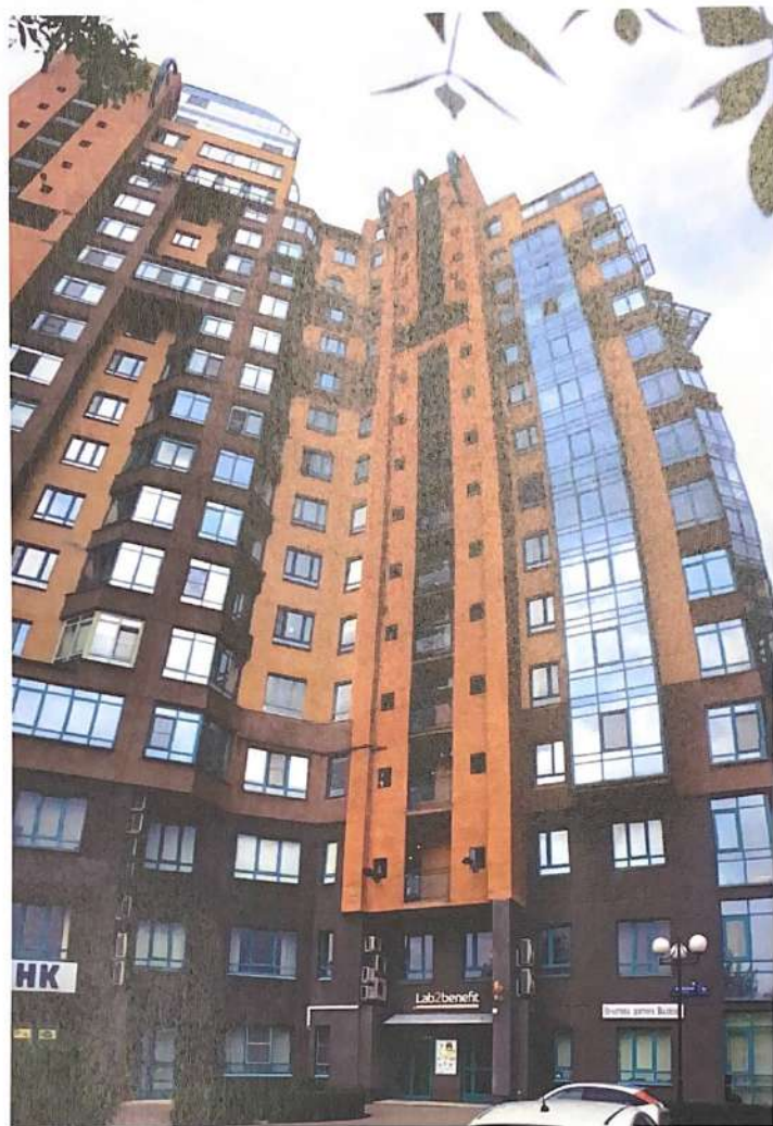
Фото 2. Секция 7. По исполнительной схеме Фасад 1.
