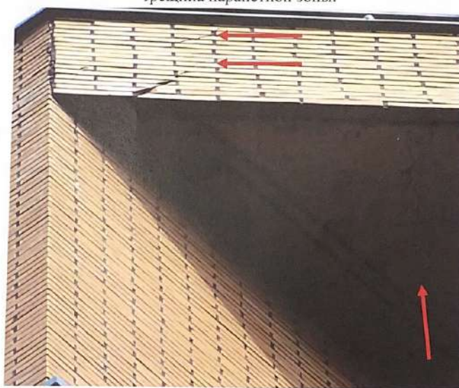
Фото 20. Ось Е1 758 Диагональные трещины наружной версты. Вертикальная трещина парапетной зоны.
