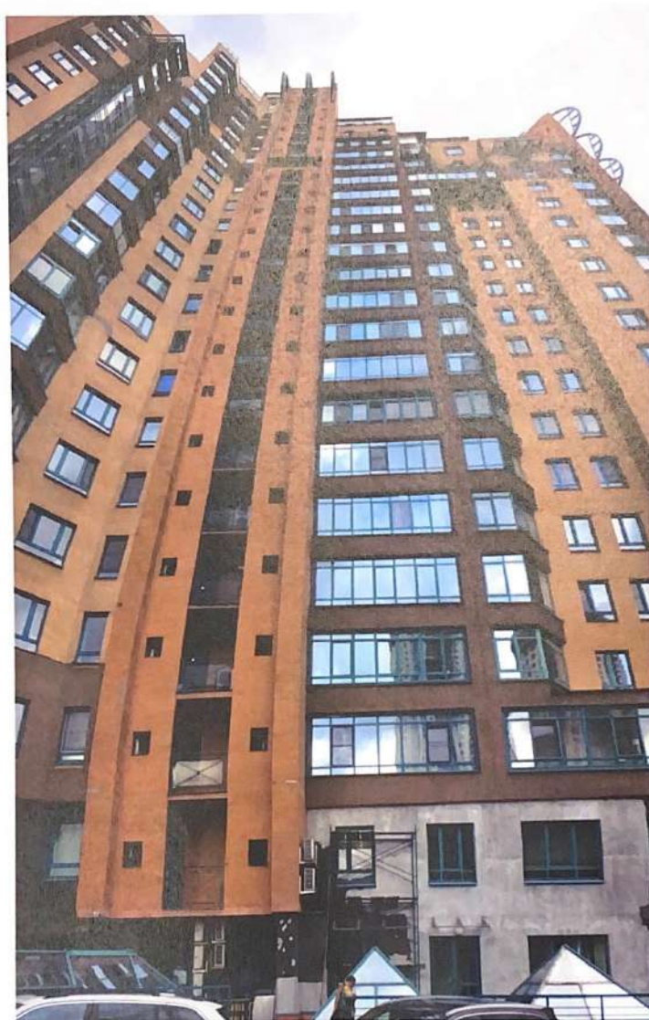
Фото 7. Секция 11. По исполнительной схеме Фасад 2.
