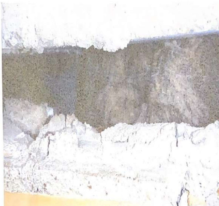
Фото 162. Секция 11/12. Фасад №2. Отсутствие деформационных швов. Сквозные отверстия внутрь конструкции стены - полное отсутствие защиты от атмосферных воздействий.
