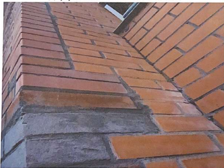
Фото 96. Секция 11. Фасад 2. Участок восстановления кирпичной кладки фасада- значительных повреждений не выявлено. Торце плиты оштукатурен. Деформационный шов не выполнен.
