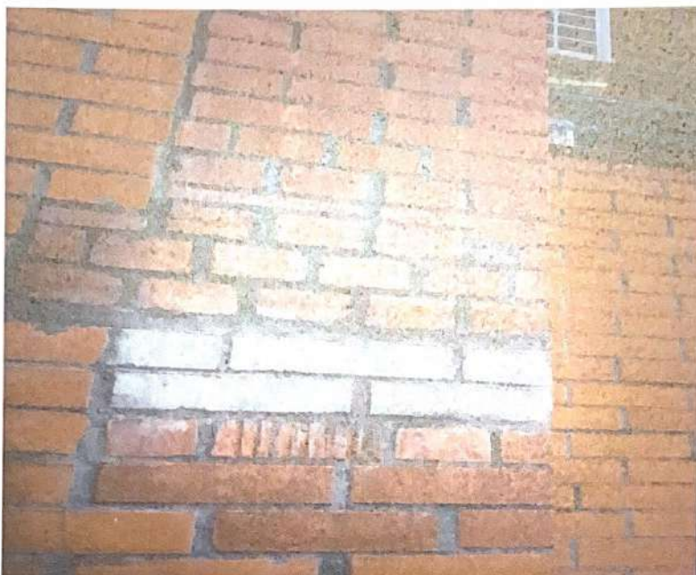
Фото 95. Секция 11. Фасад 2. Участок восстановления кирпичной кладки фасада- значительных повреждений не выявлено. Торце плиты оштукатурен. Деформационный шов не выполнен.
