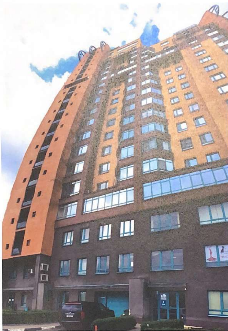
Фото 4. Секция 9. По исполнительной схеме Фасад 1.
