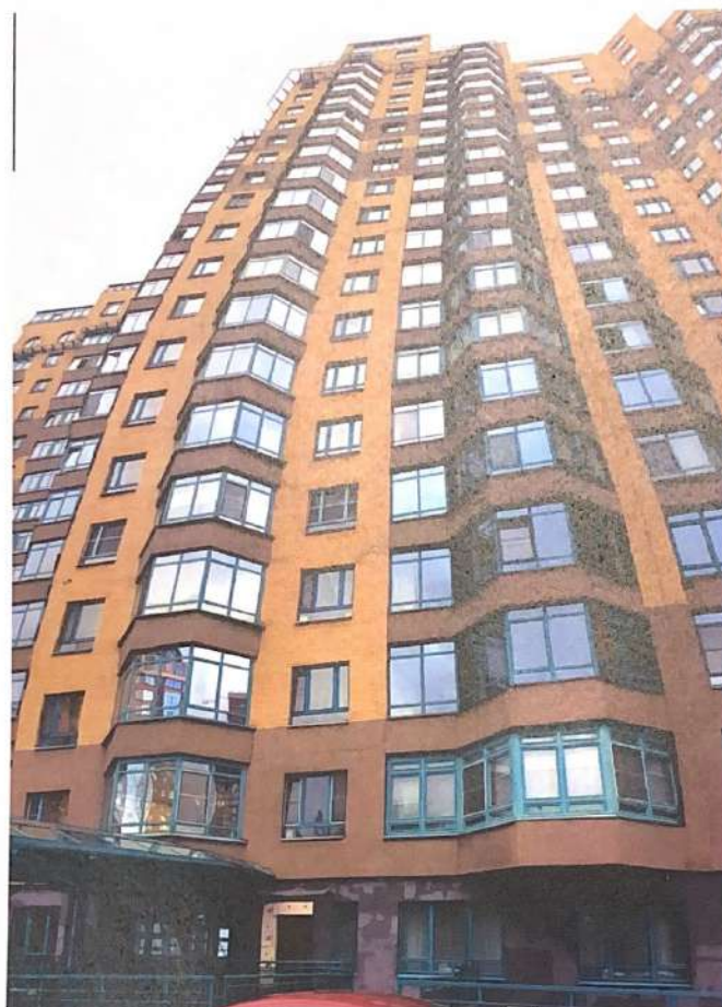
Фото 13. Секция 11. Дворовой фасад.. Ось G18-G26. По исполнительной схеме Фасад 3.
