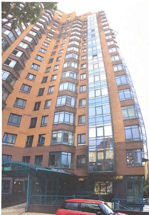
Фото 12. Секция 12. Ось E22. Дворовой фасад.
