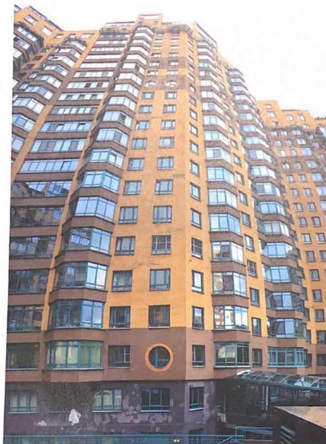
Фото 14. Секция 11. Ось E13. Дворовой фасад.
